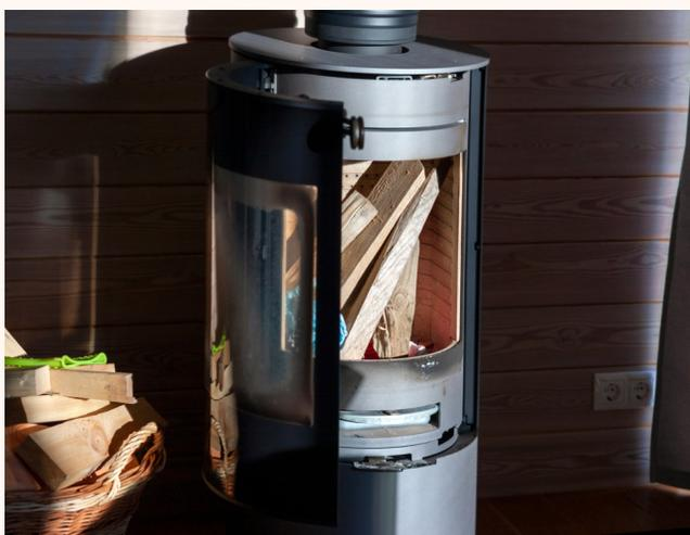
**La norme canadienne CAN/CSA-B415.1** établit que le rapport air-combustible moyen doit être inférieur à 35:1 pour être conforme.
